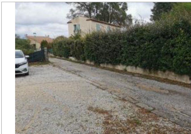
Vue du site, auteur: OTEIS, 2023
