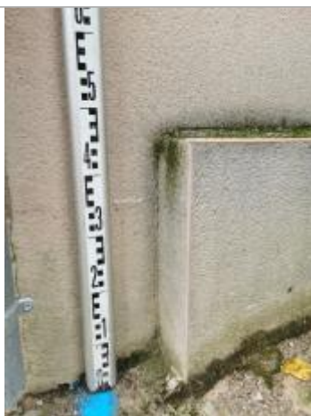
Vue du repère, auteur: OTEIS, 2023
