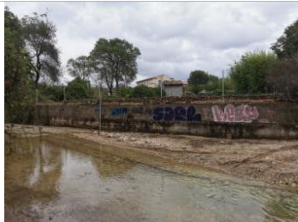
Vue du site, auteur: OTEIS, 2023
