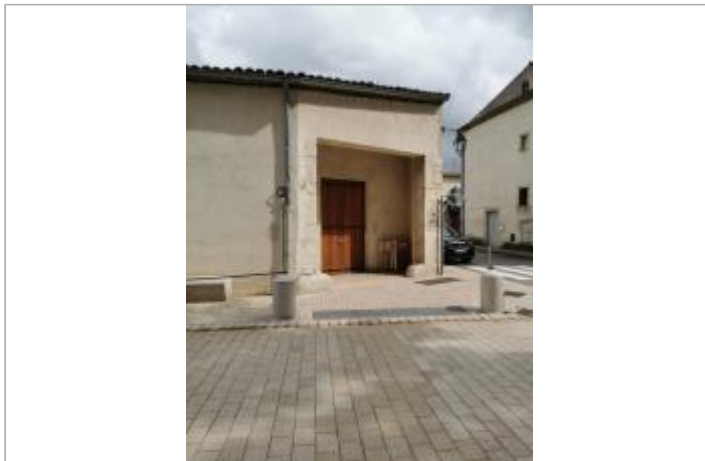
Vue du site, auteur: OTEIS, 2023
