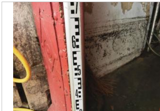
Vue du repère, auteur: OTEIS, 2023
