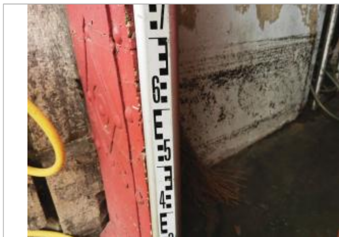
Vue du repère, auteur: OTEIS, 2023
