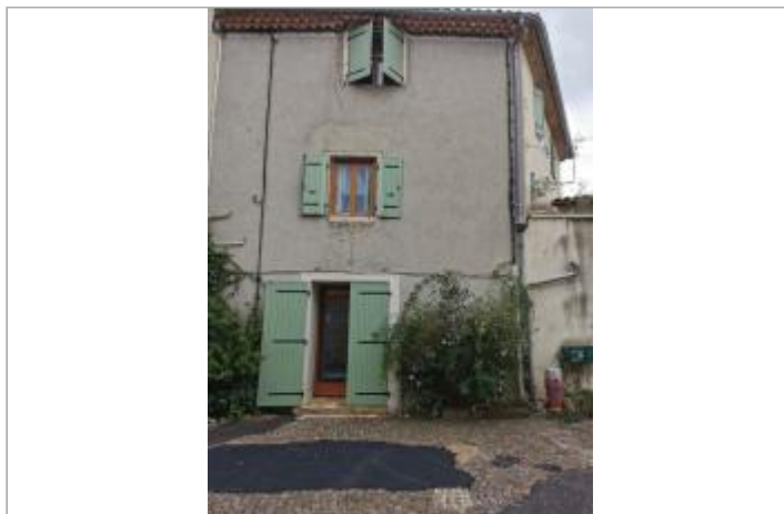
Vue du site, auteur: OTEIS, 2023
