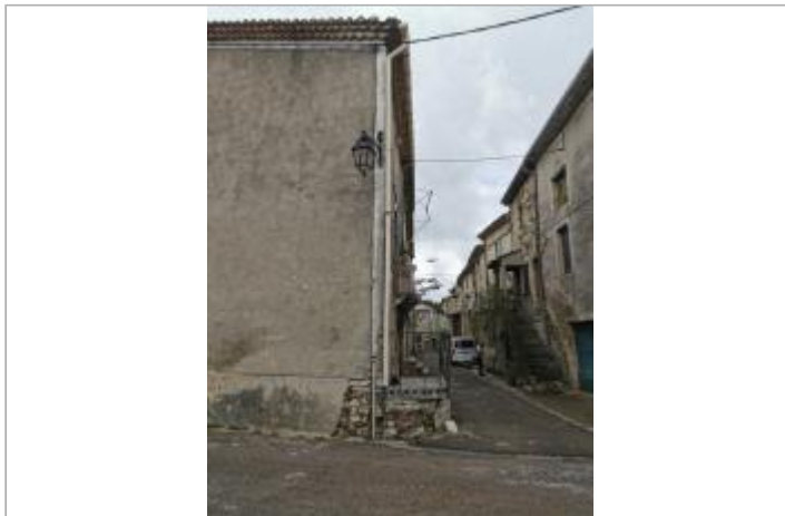
Vue du site, auteur: OTEIS, 2023
