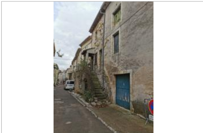
Vue du site, auteur: OTEIS, 2023
