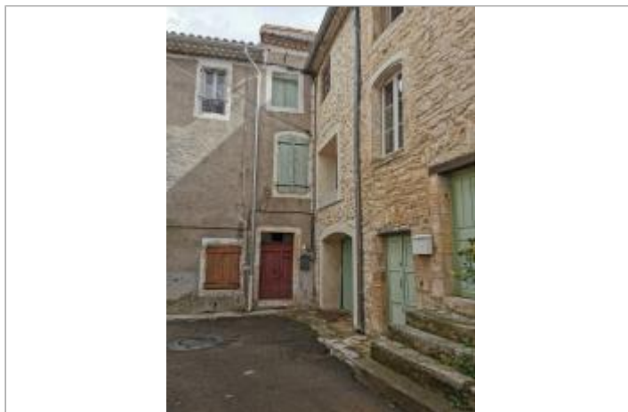
Vue du site, auteur: OTEIS, 2023
