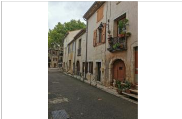
Vue du site, auteur: OTEIS, 2023
