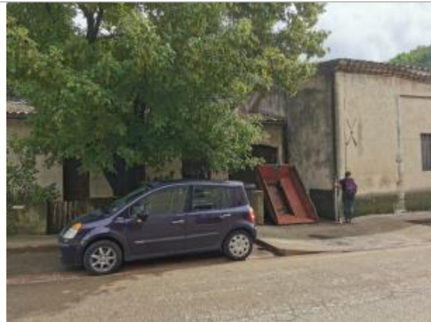
Vue du site, auteur: OTEIS, 2023
