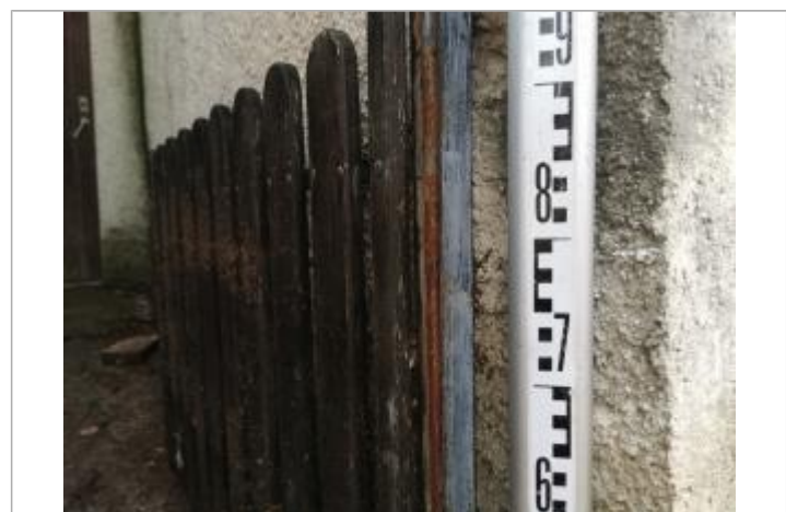
Vue du repère, auteur: OTEIS, 2023
