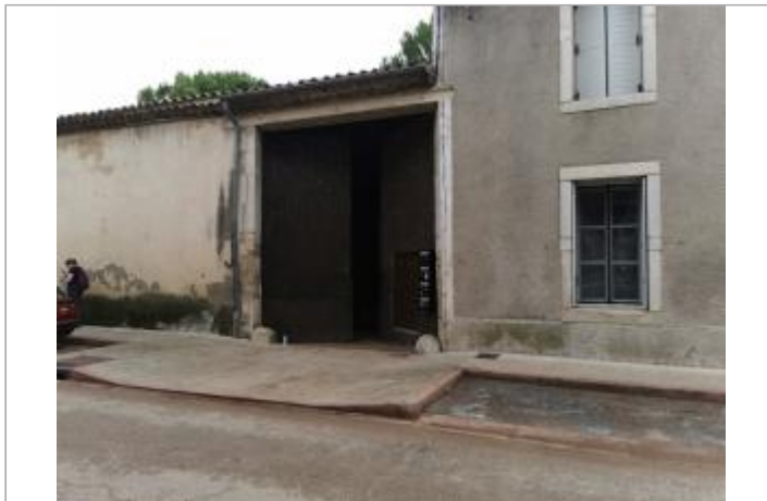
Vue du site, auteur: OTEIS, 2023
