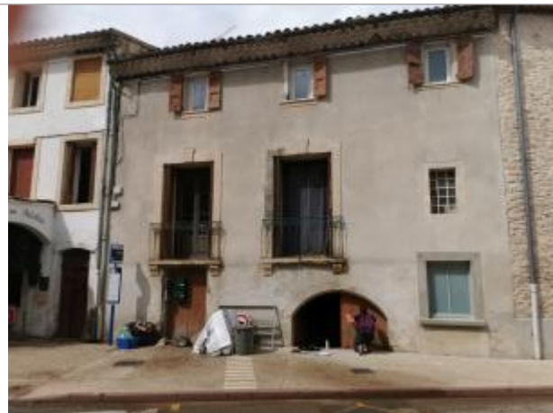
Vue du site, auteur: OTEIS, 2023
