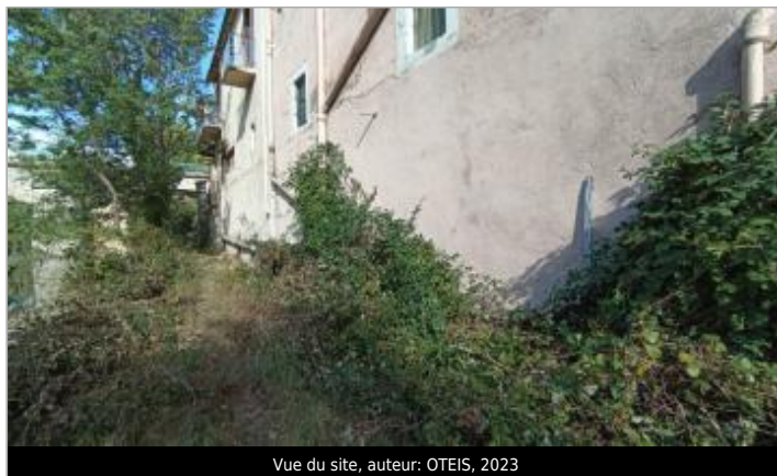
Vue du site, auteur: OTEIS, 2023
