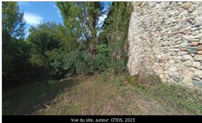
Vue du site, auteur: OTEIS, 2023
