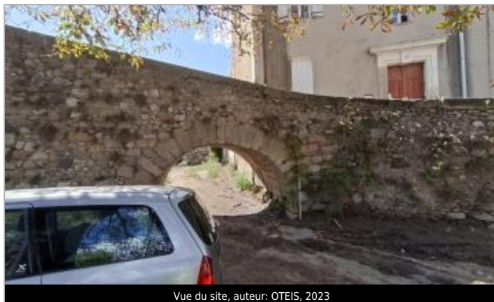
Vue du site, auteur: OTEIS, 2023
