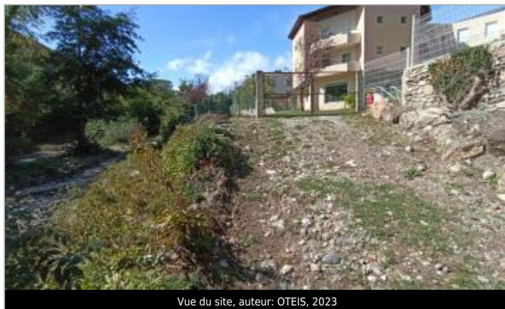
Vue du site, auteur: OTEIS, 2023
