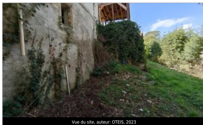
Vue du site, auteur: OTEIS, 2023
