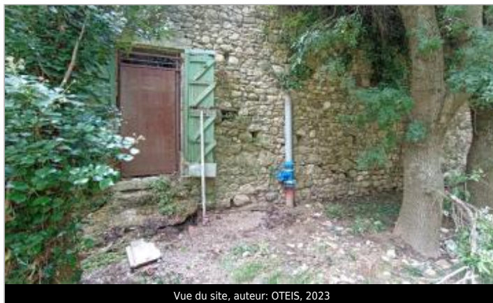
Vue du site, auteur: OTEIS, 2023
