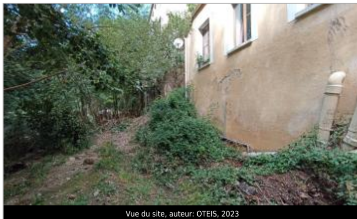
Vue du site, auteur: OTEIS, 2023
