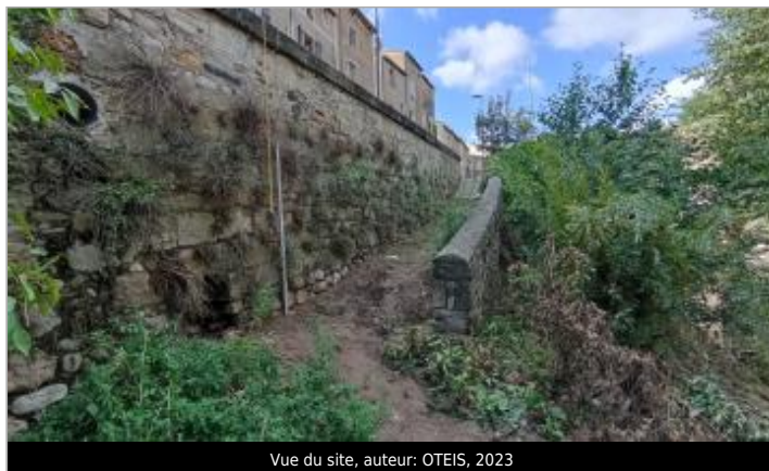
Vue du site, auteur: OTEIS, 2023
