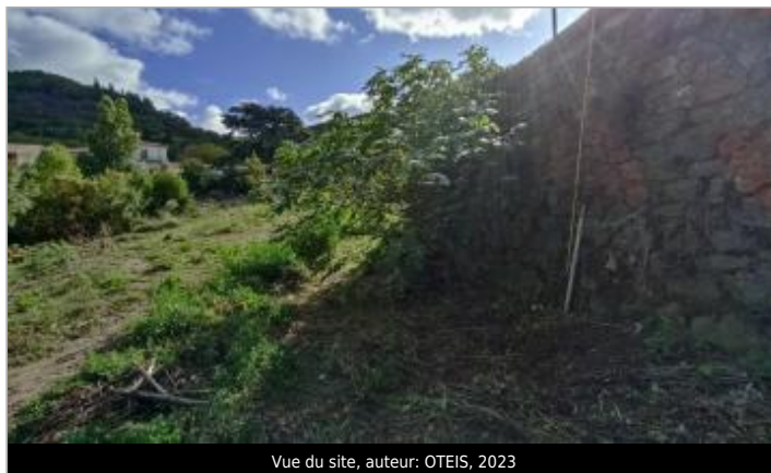
Vue du site, auteur: OTEIS, 2023
