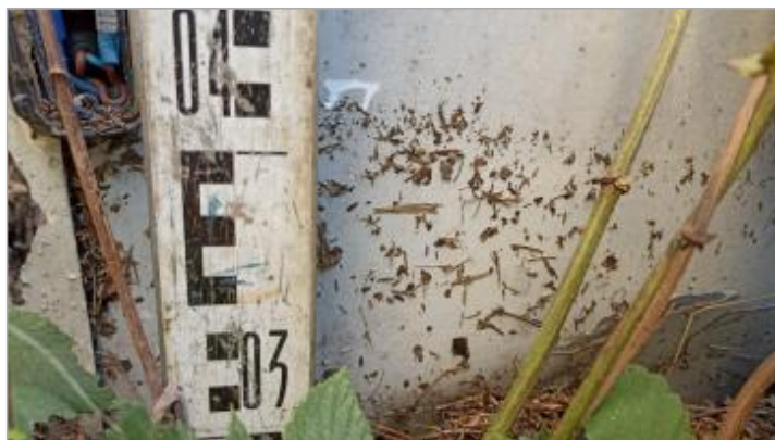
Vue du repère, auteur: OTEIS, 2023
