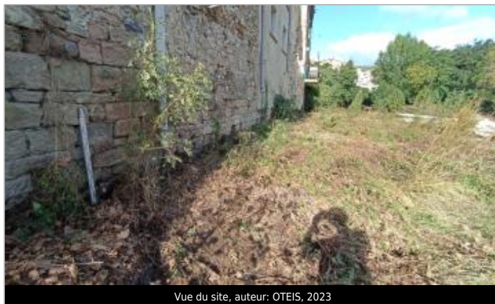
Vue du site, auteur: OTEIS, 2023
