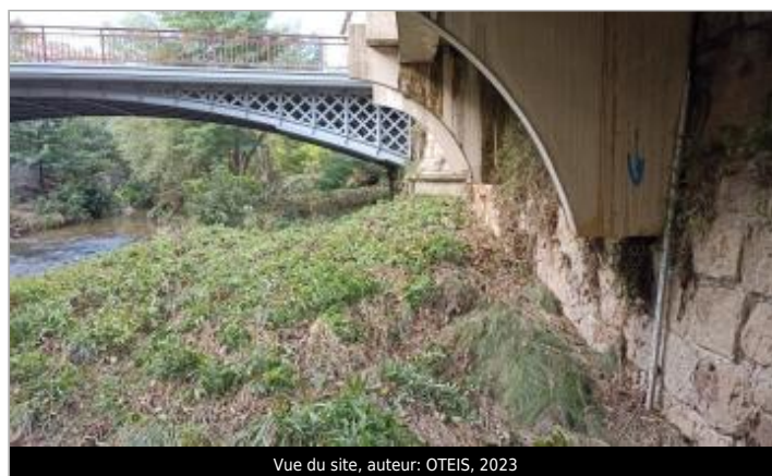
Vue du site, auteur: OTEIS, 2023
