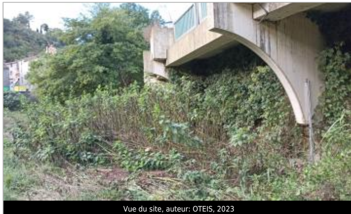
Vue du site, auteur: OTEIS, 2023
