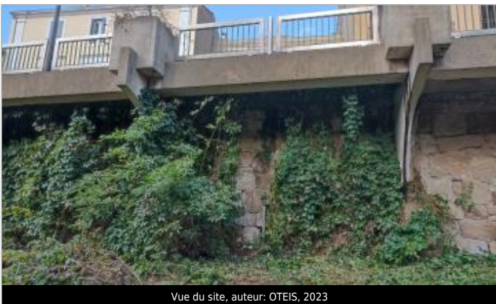
Vue du site, auteur: OTEIS, 2023
