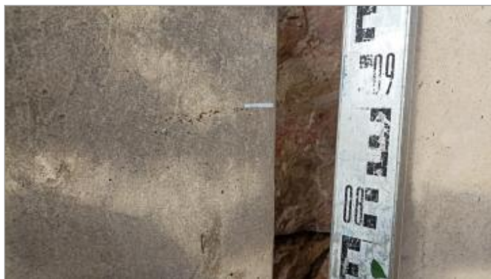
Vue du repère, auteur: OTEIS, 2023
