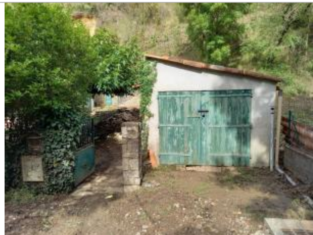
Vue du site, auteur: OTEIS, 2023
