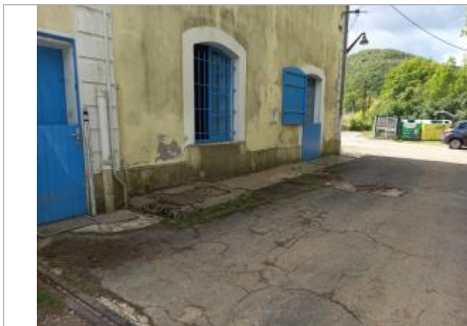
Vue du site, auteur: OTEIS, 2023
