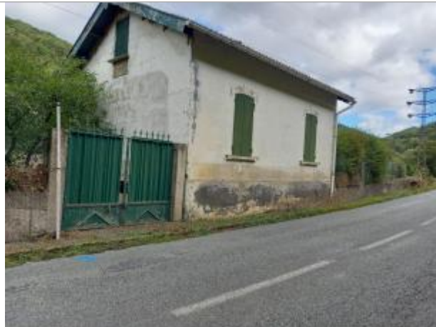
Vue du site, auteur: OTEIS, 2023
