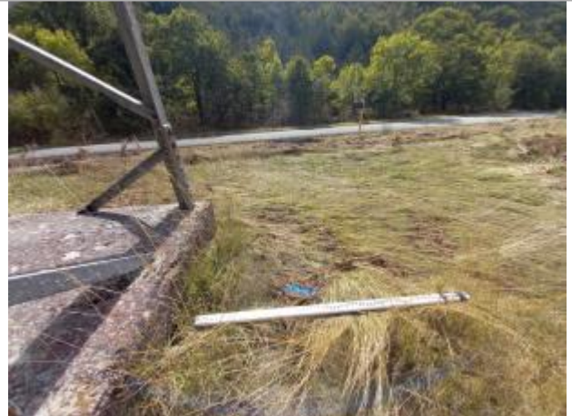
Vue du site, auteur: OTEIS, 2023
