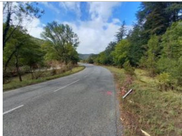
Vue du site, auteur: OTEIS, 2023
