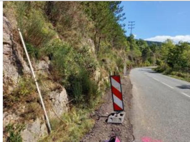
Vue du site, auteur: OTEIS, 2023
