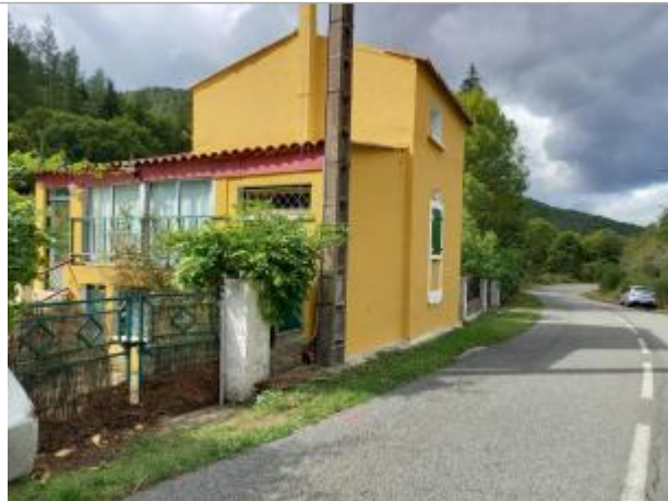
Vue du site, auteur: OTEIS, 2023
