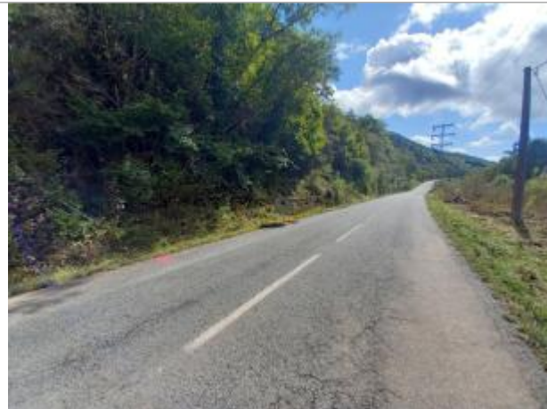
Vue du site, auteur: OTEIS, 2023
