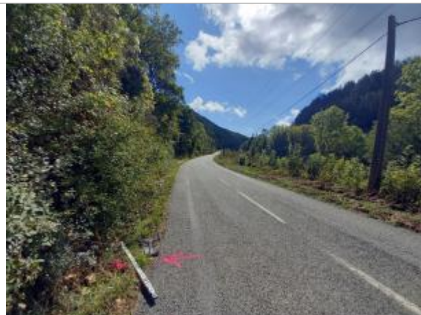
Vue du site, auteur: OTEIS, 2023
