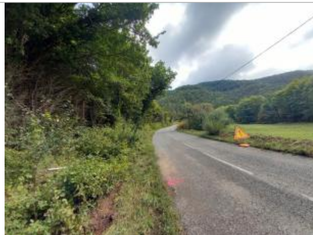
Vue du site, auteur: OTEIS, 2023
