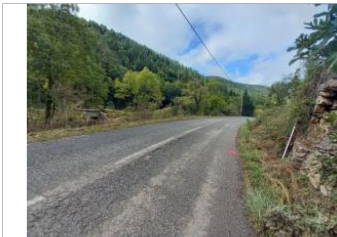
Vue du site, auteur: OTEIS, 2023
