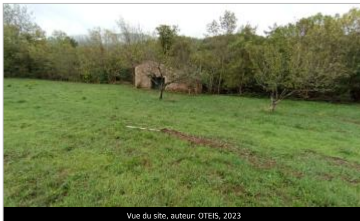
Vue du site, auteur: OTEIS, 2023
