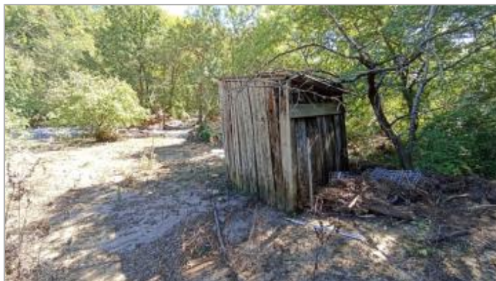
Vue du site, auteur: OTEIS, 2023
