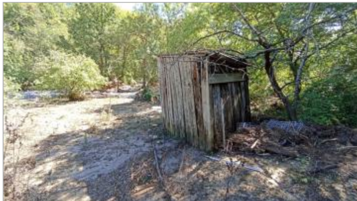
Vue du site, auteur: OTEIS, 2023
