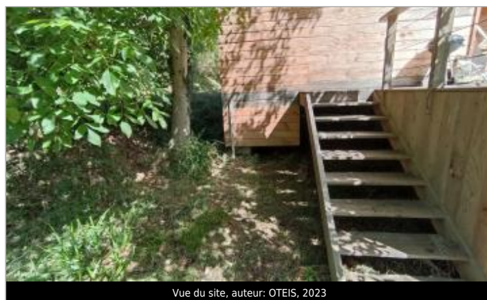
Vue du site, auteur: OTEIS, 2023
