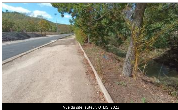
Vue du site, auteur: OTEIS, 2023
