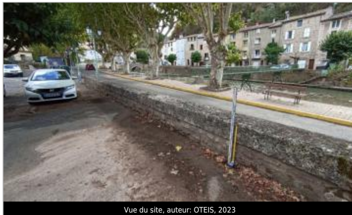
Vue du site, auteur: OTEIS, 2023
