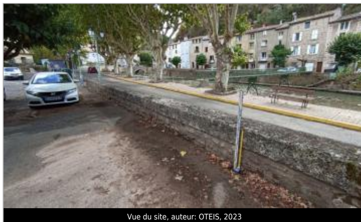
Vue du site, auteur: OTEIS, 2023
