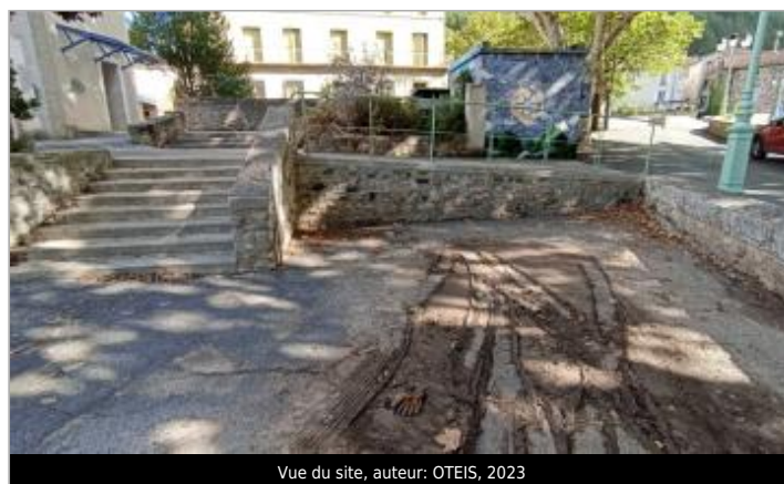
Vue du site, auteur: OTEIS, 2023
