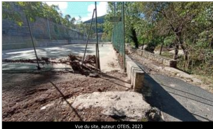
Vue du site, auteur: OTEIS, 2023
