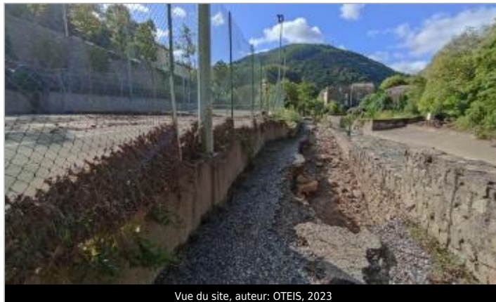
Vue du site, auteur: OTEIS, 2023
