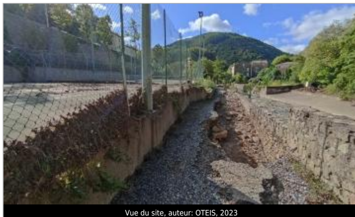
Vue du site, auteur: OTEIS, 2023
