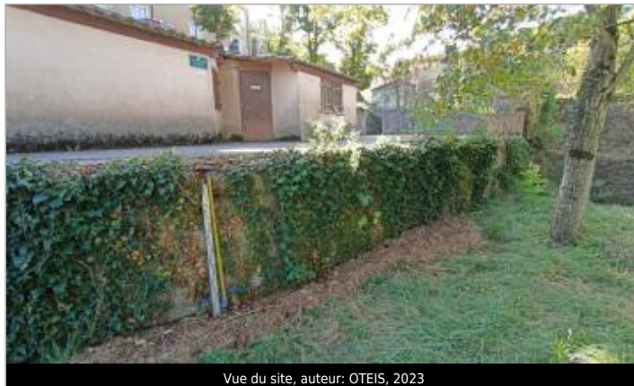
Vue du site, auteur: OTEIS, 2023
