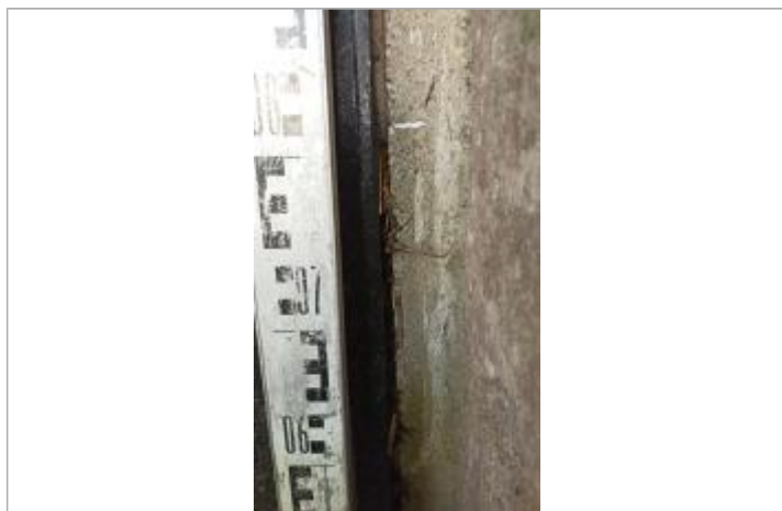
Vue du repère, auteur: OTEIS, 2023
