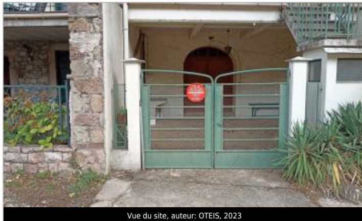
Vue du site, auteur: OTEIS, 2023
